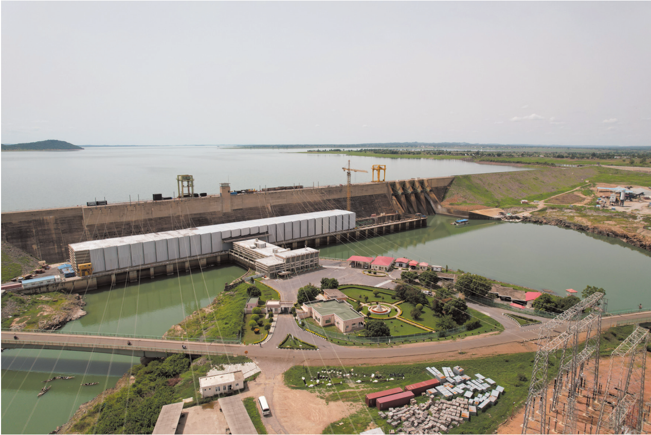
这是2024年6月4日在尼日利亚尼日尔州拍摄的卡因吉水电站。
