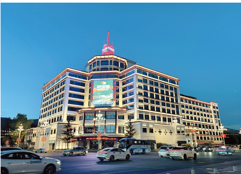
图为风貌整治提升后的拉萨电信大厦外观焕然一新。 拉萨融媒记者 仁青拉姆摄
