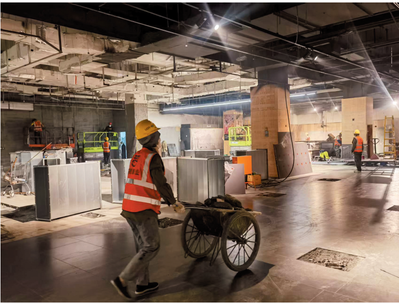
图为永辉超市纳金东路店自主调改施工现场。
