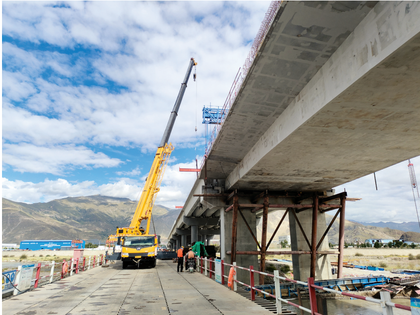
图为聂当特大桥主体完工。
