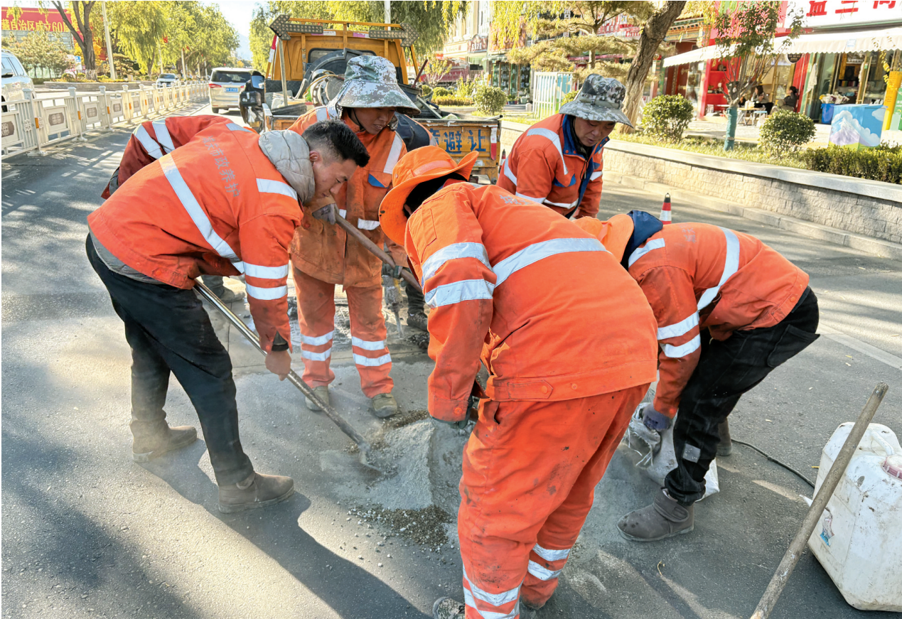
图为维修施工现场。
