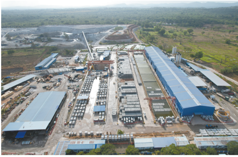
图为2026年1月19日拍摄的斯里兰卡埃勒黑勒运河引水隧洞项目施工现场(无人机照片)。(新华社发)
