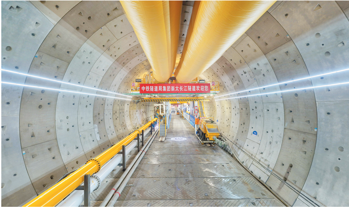
9月9日,世界最大直径高铁盾构机“领航号”在崇太长江隧道2号竖井顺利完成二次始发。由上海国铁建管公司建设、中铁隧道局承建的崇太长江隧道是沪渝蓉沿江高铁沪宁段的关键控制性工程,连接上海崇明与江苏太仓,其中盾构段长13.20公里。 图为9月9日在江苏太仓拍摄的由中铁隧道局施工的盾构隧道(无人机照片)。(新华社发)
