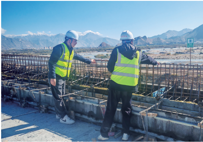
图为施工人员对桥面防撞护栏钢筋尺寸进行测量，严把工程质量关。拉萨融媒记者 次珍 摄
